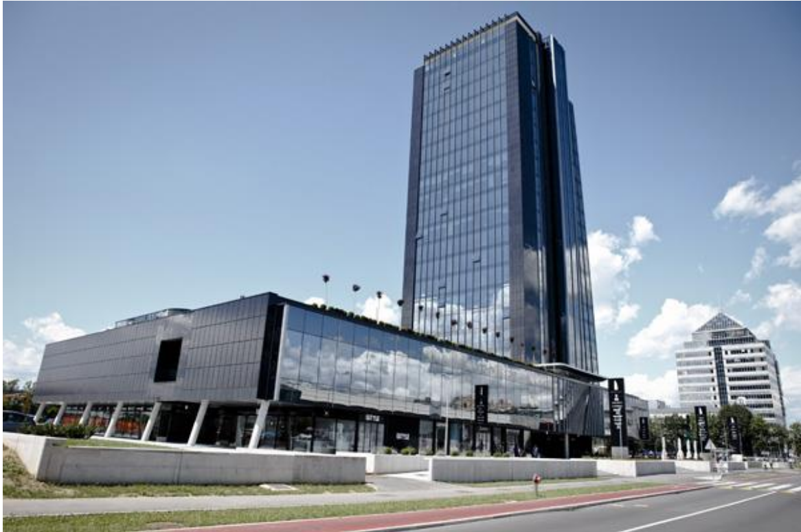
Kristalna palača v BTC v Ljubljani – sončni moduli so arhitekturno vkomponirani v levi in desni rob južne fasade in celoten sprednji del nižje južne fasade.
